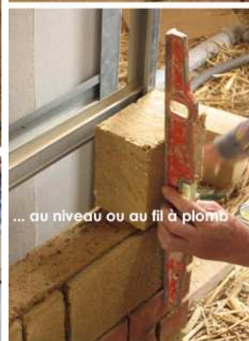
montage du mur de BTC au mortier de terre
